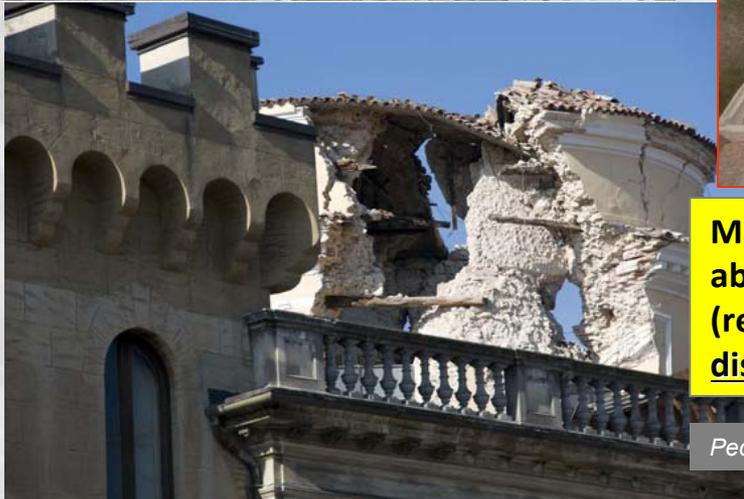
**Malta di scarsa qualità, costituita da abbondante aggregato e scarso legante (realizzato con calce e terra) → disintegrazione delle strutture**
